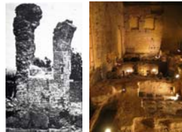
Mur sud thermes Thermes d'Entrammes
